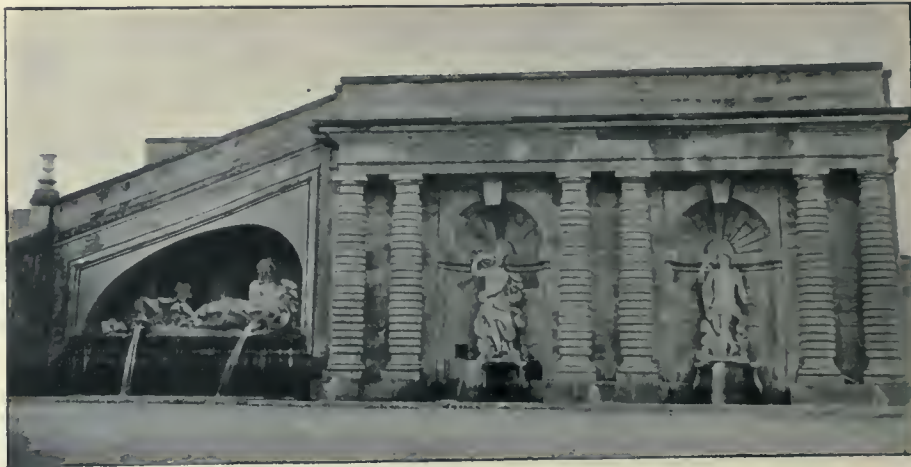
CHANTILLY, côté droit du grand Degré (exécuté par Jean Hardy, d'après les dessins de Le Nôtre).
